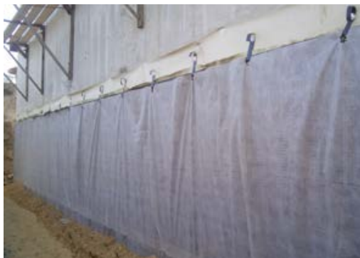
Пристенный дренаж и защита гидро- изоляции
